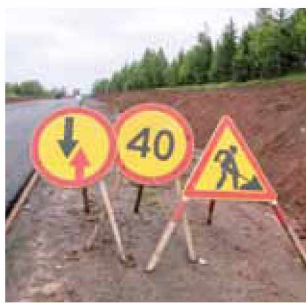
Если дорожное основание разрушено, нет «подушки» из щебня и песка, ремонтировать верхний слой дорожного полотна практически бесполезно.
