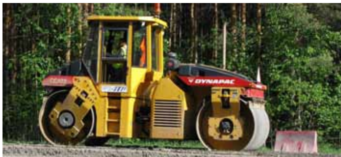
Каток Динапас СС422 работает на замене слоя износа на всю ширину покрытия
