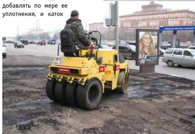
Каток Динапас СС422 работает на замене слоя износа на всю ширину покрытия
