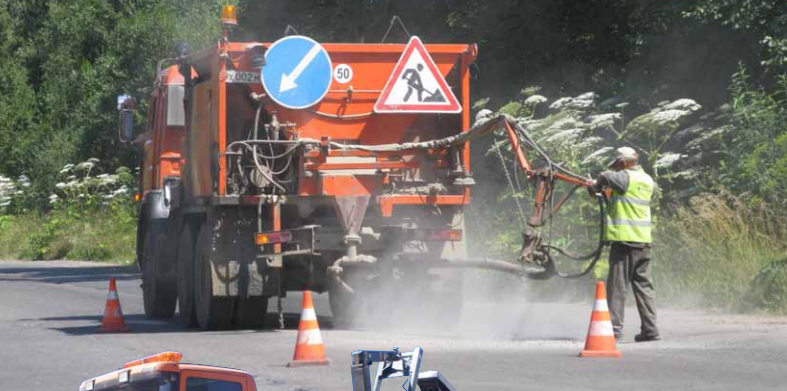
Машина для ямочного ремонта пневмонабрызгом КДМ-316 из Брянска на шасси КамАЗ-65115-62
